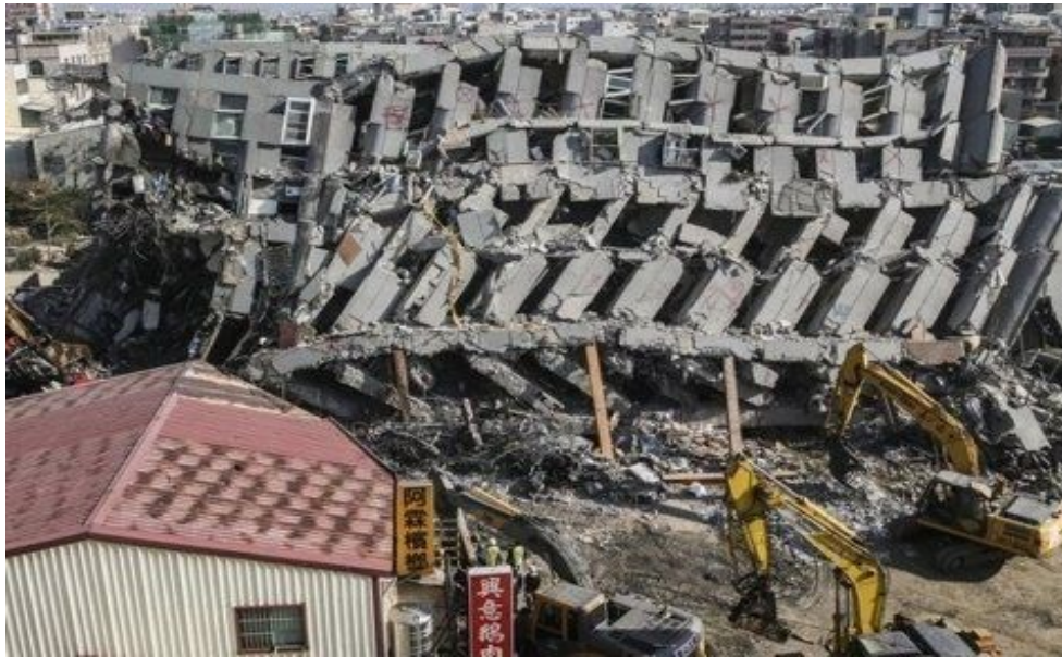
2016.二〇六地震 震垮台南多棟大樓
